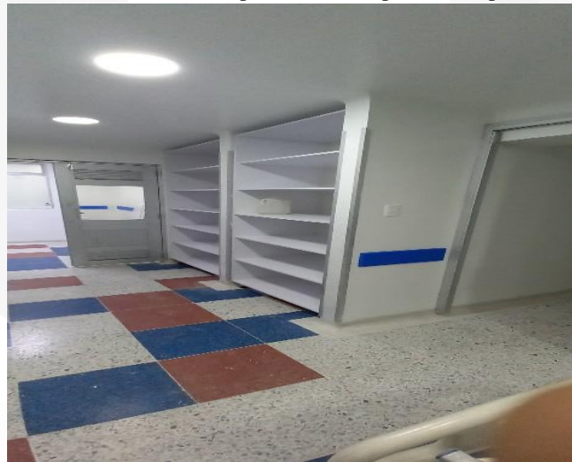
Adecuacion de muelles para area de expansion respiratoria
